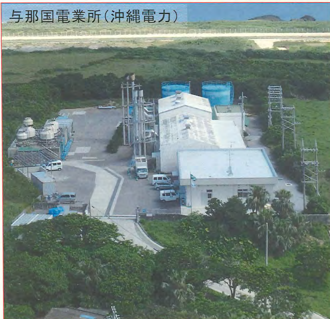
太陽光発電設備
