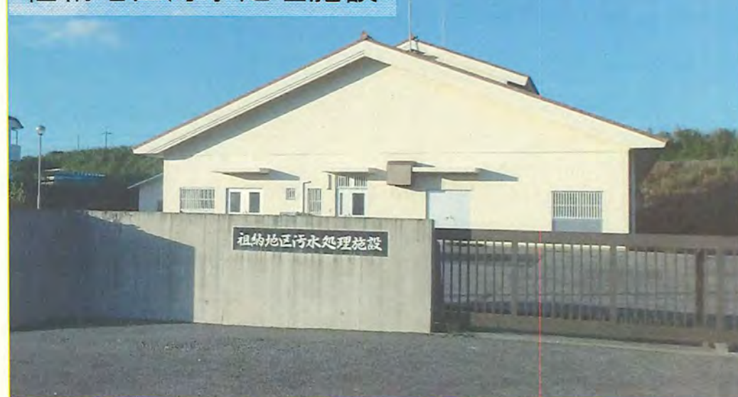
祖納地区汚水処理施設
